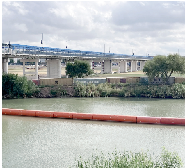
La barrera de boyas flotantes puede observarse debajo de los Puentes Internacionales de Eagle Pass, sobre el cauce del río Bravo.
