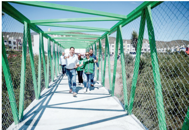
El alcalde Javier Díaz González entregó el nuevo puente peatonal construido en Hacienda Narro.
