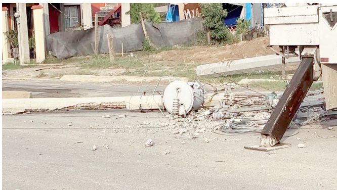
Provocó la caída de postes y daños en infraestructura eléctrica.
