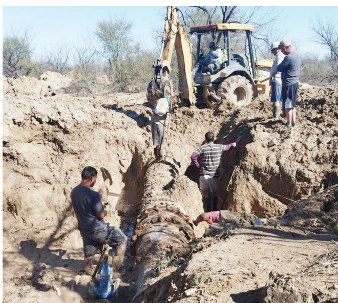
Personal del organismo mantiene labores permanentes para reparar fugas y dar mantenimiento a la red de drenaje del municipio.
