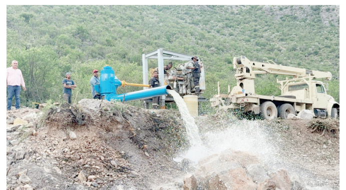
El proyecto contempla mejorar la eficiencia del suministro de agua.
