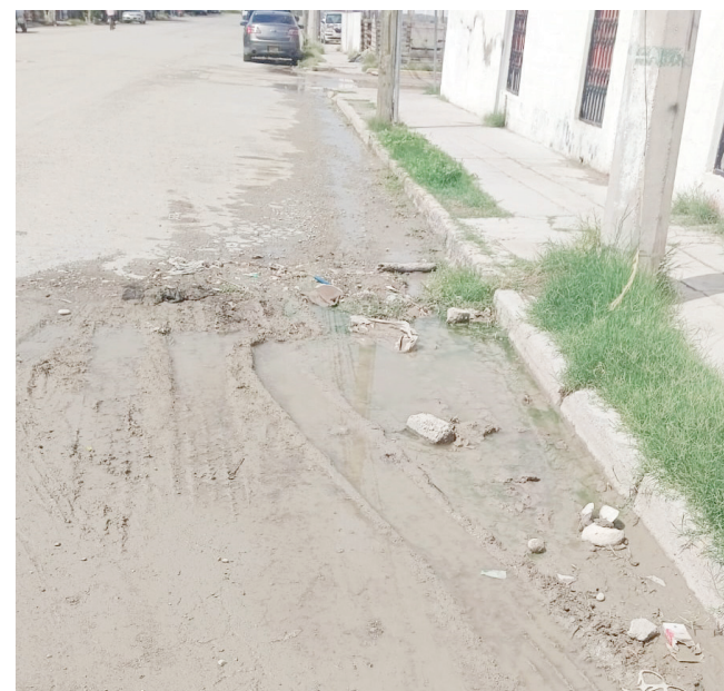
Aguas negras continúan afectando las calles de la Colonia Las Vírgenes.
