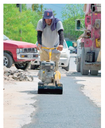
Se atendieron baches y rupturas, además de colocar bordos pluviales para mejorar la infraestructura.
