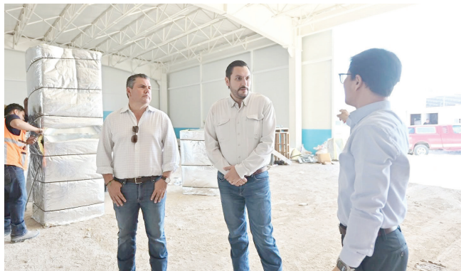
Avanza construcción de planta para autos eléctricos.
