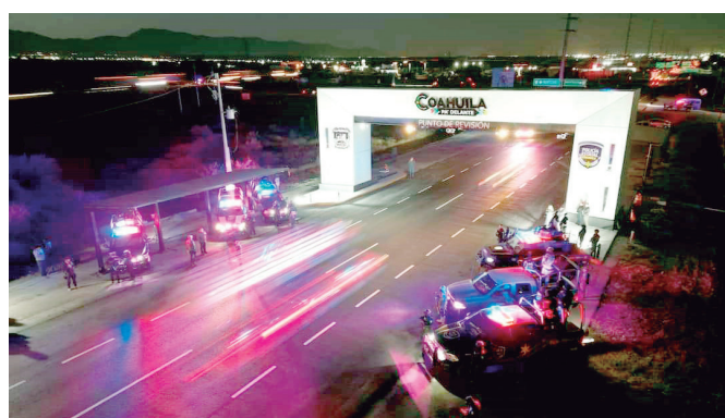
El nuevo arco está instalado en la carretera Saltillo-Monterrey.
